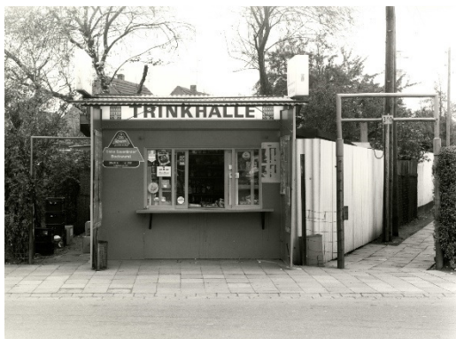
Trinkhalle Düsseldorf Höherweg 300
